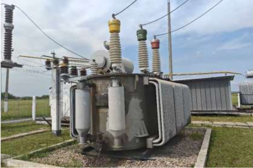
«До» замены высоковольтных вводов 110 кВ
