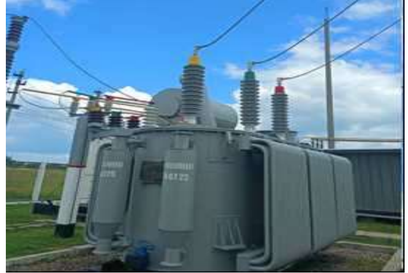
«После» замены высоковольтных вводов 110 кВ
