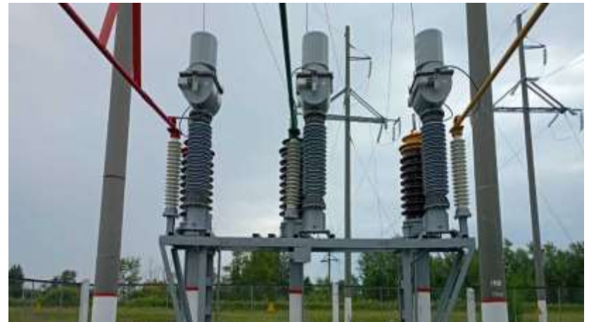
«После» замены трансформаторов тока 110 кВ
