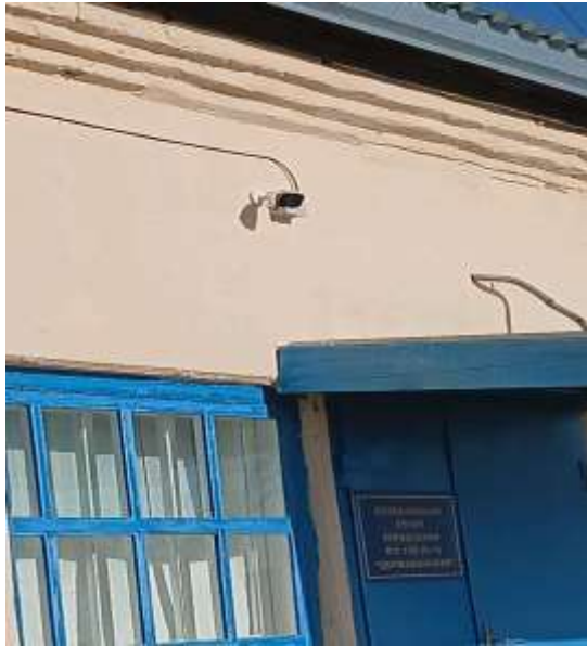
Монтаж системы видеонаблюдения
