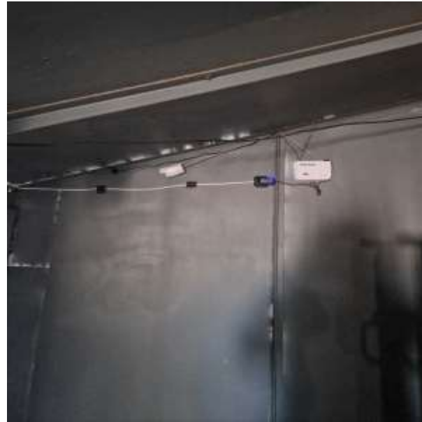
Монтаж охранной сигнализации на объектах
