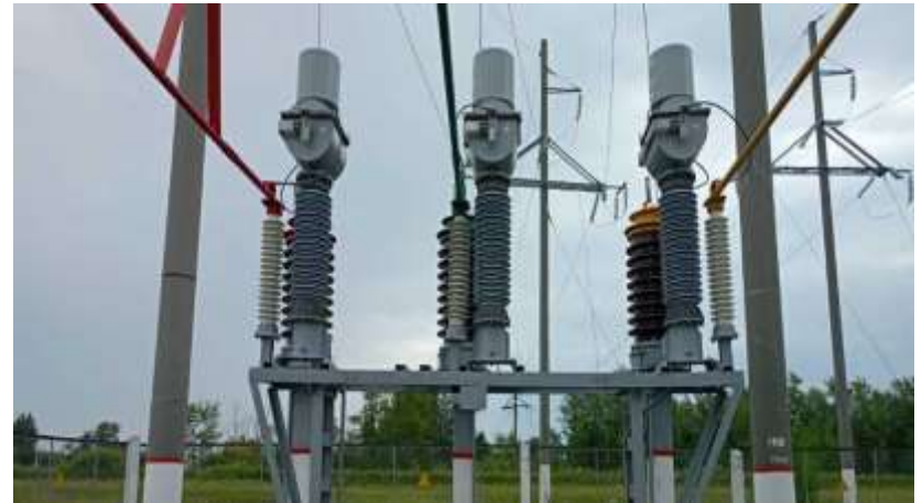
«После» замены трансформаторов тока 110 кВ
