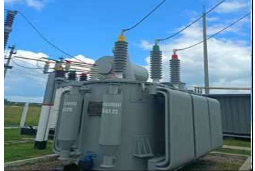
«После» замены высоковольтных вводов 110 кВ
