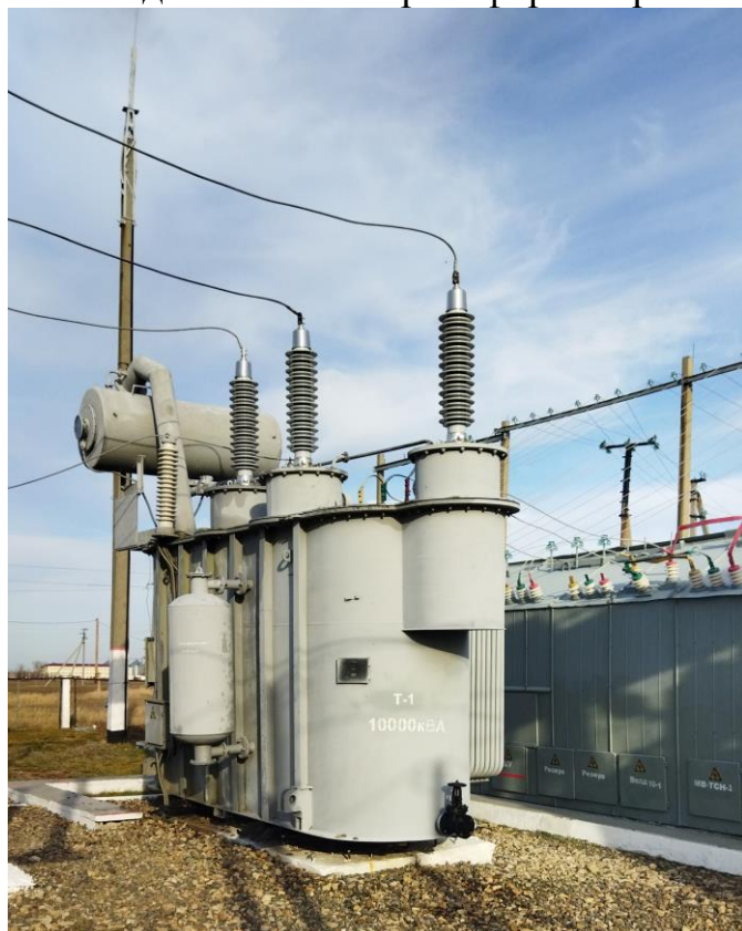
Фото после замены высоковольтных вводов силового трансформатора
