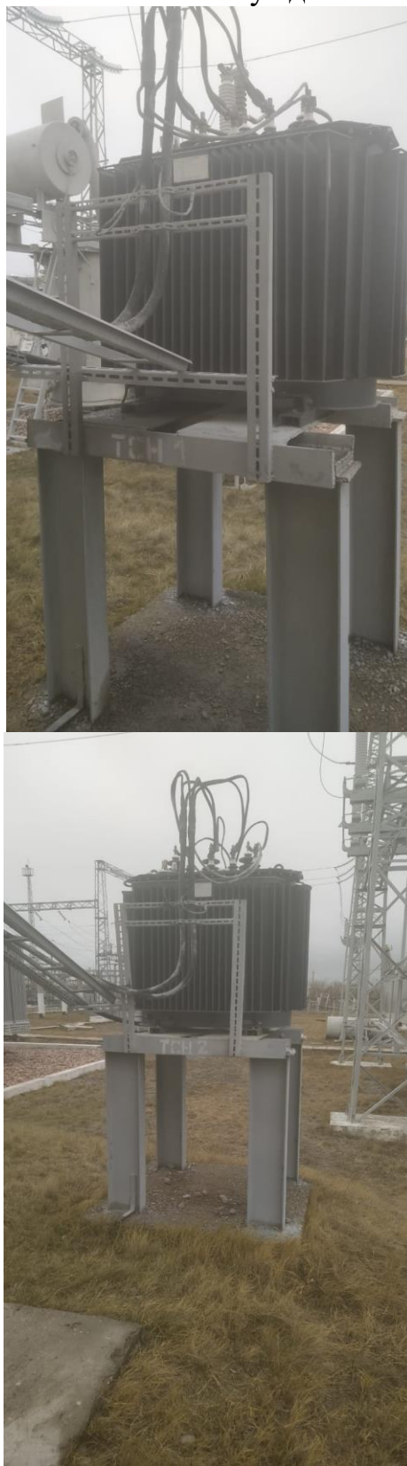
Фото после замены трансформаторов собственных нужд 6 кВ
