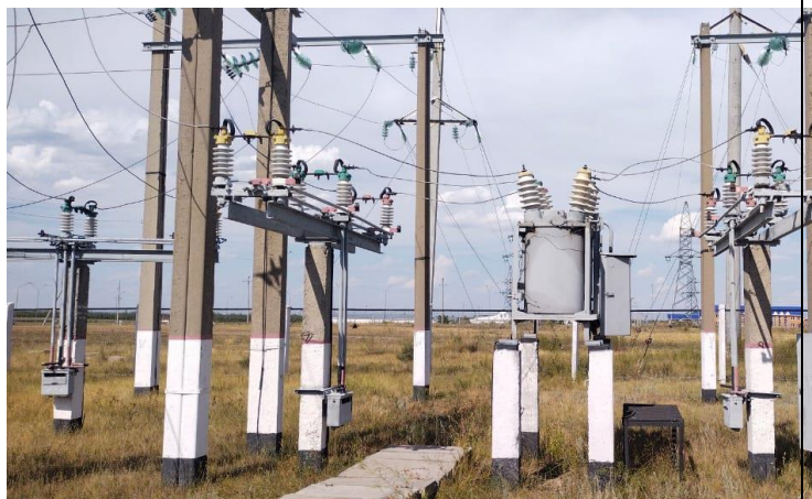
Фото до замены масляного выключателя 35 кВ
