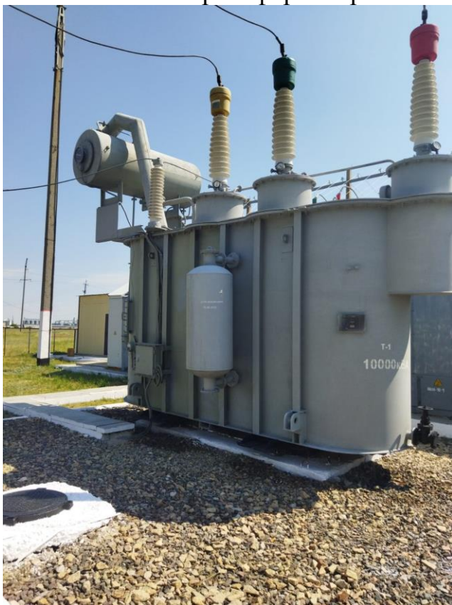
Фото до замены высоковольтных вводов силового трансформатора
