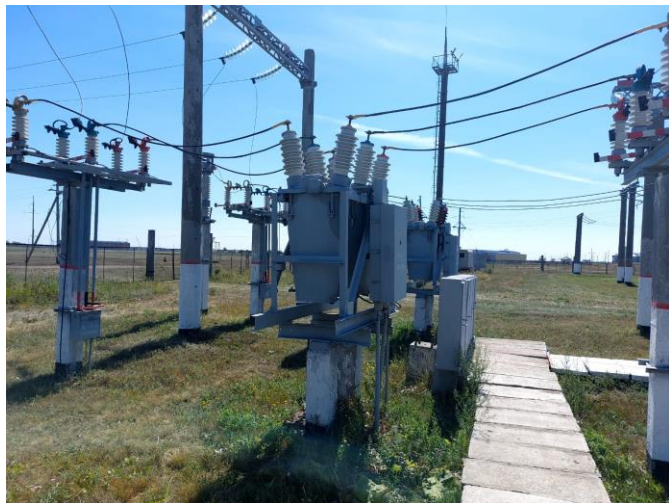
Фото до демонтажа масляных выключателей 35 кВ
