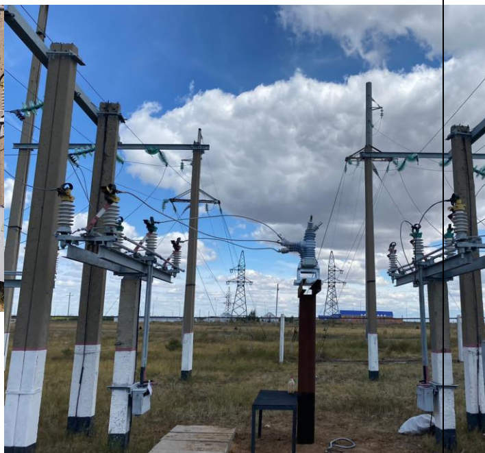
Фото после замены масляного выключателя 35 кВ
