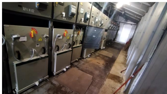
Фото после замены трансформаторов
