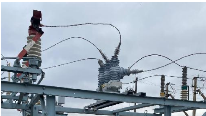
«После» монтажа вакуумных выключателей 35 кВ
