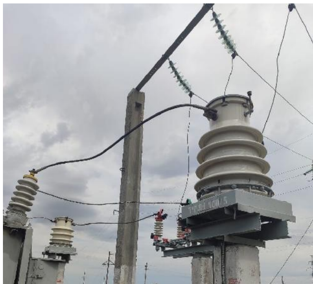
«До» замены трансформаторов напряжения 10 кВ
