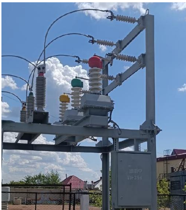
«До» замены трансформаторов напряжения 35 кВ
