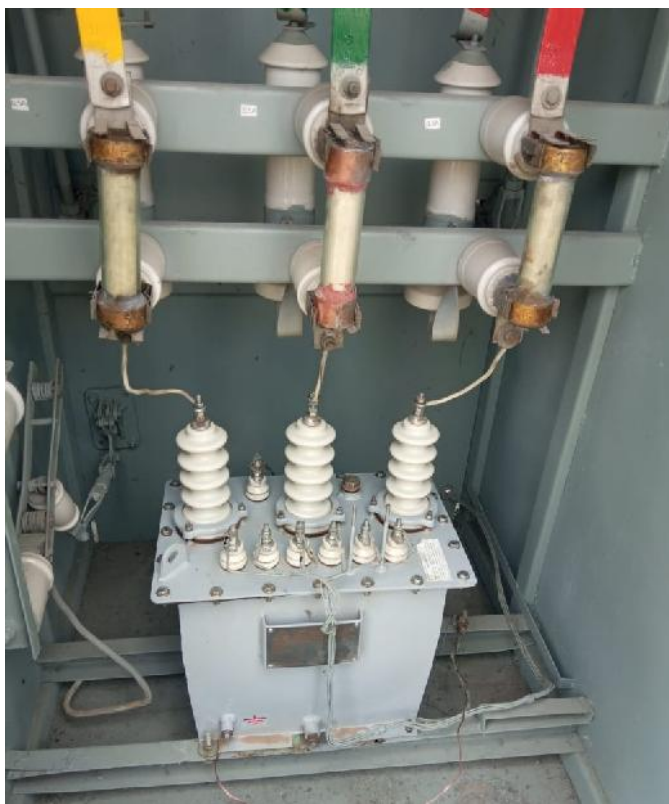
«После» замены трансформаторов напряжения 10 кВ
