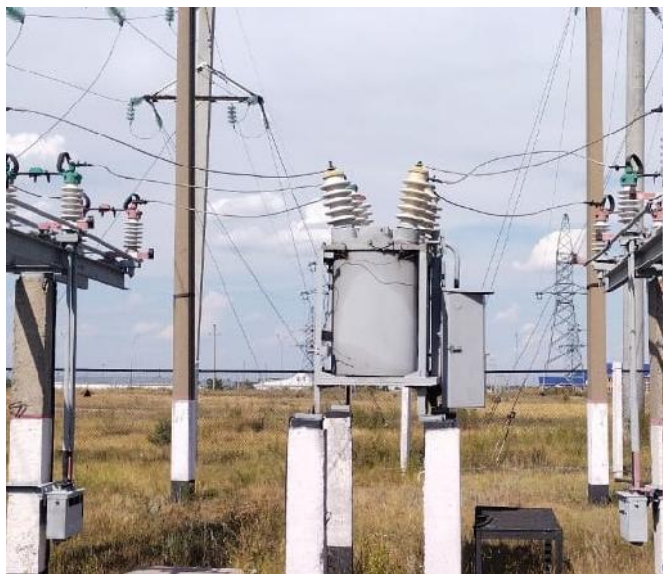
«До» замены масляных выключателей 35 кВ
