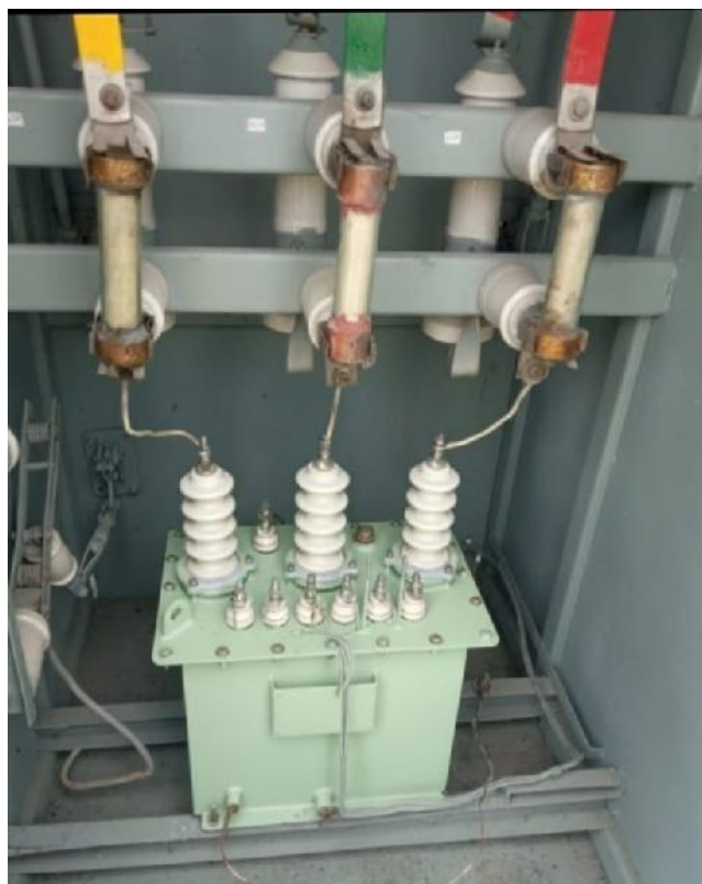
«До» замены трансформаторов напряжения 10 кВ
