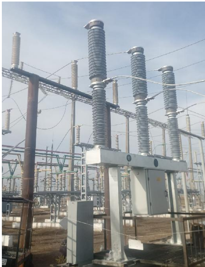
«После» монтажа элегазового выключателя 110 кВ
