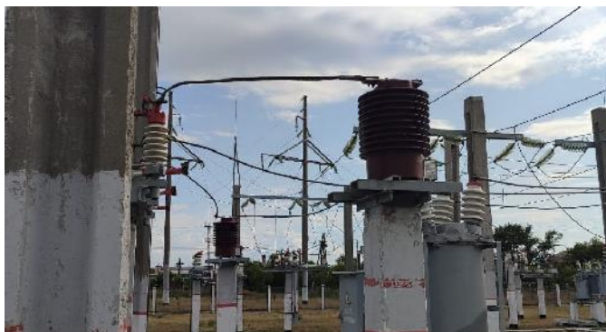
«После» замены трансформаторов тока 35 кВ
