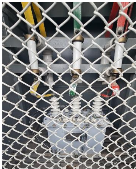
«После» замены трансформаторов напряжения 10 кВ
