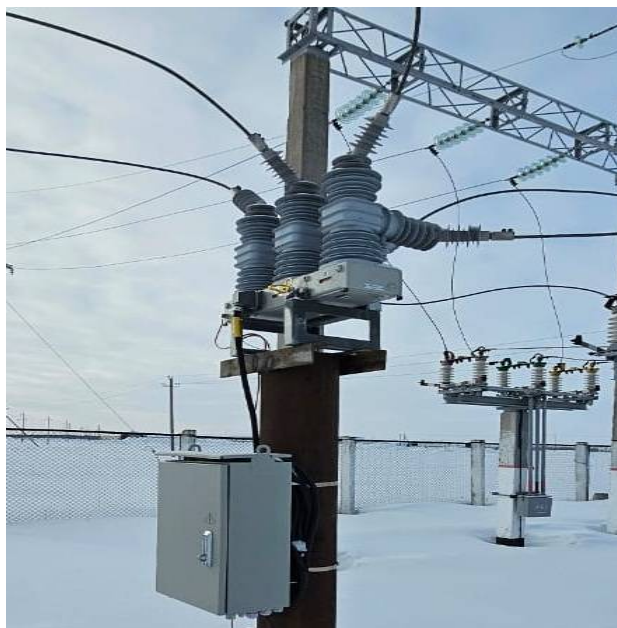
«После» монтажа вакуумных выключателей 35 кВ
