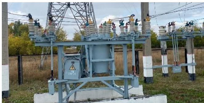
«До» замены масляных выключателей 35 кВ
