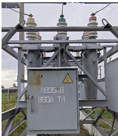
«До» замены масляных выключателей 35 кВ
