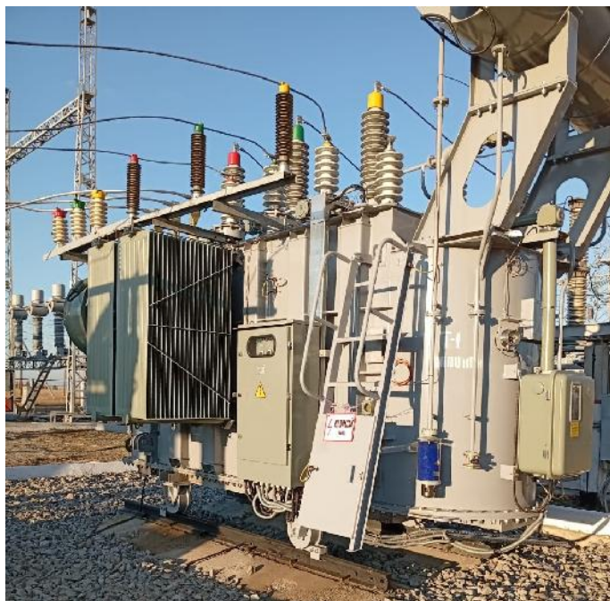
«После» замены силовых трансформаторов
