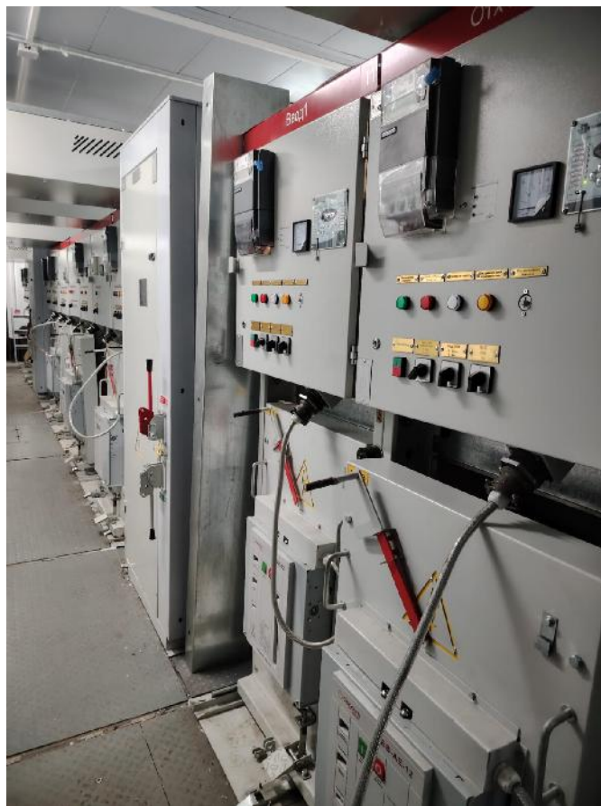
«После» монтажа вакуумных выключателей 35 кВ
