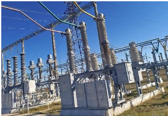
«До» замены масляного выключателя 110 кВ
