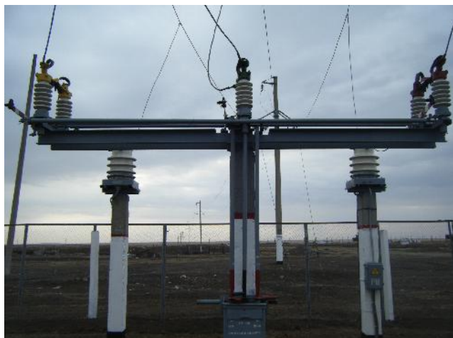
«До» замены трансформаторов тока 35 кВ
