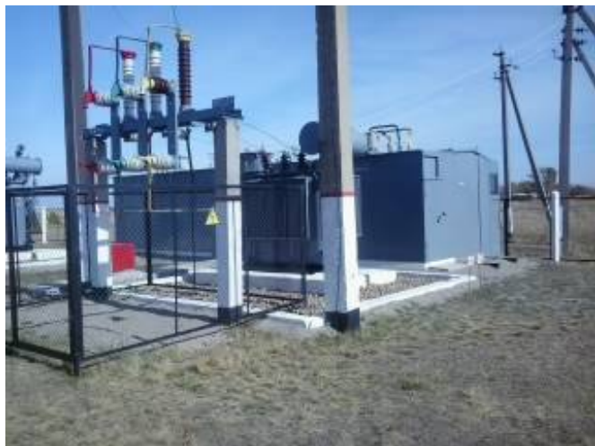
«До» замены масляных выключателей 35 кВ
