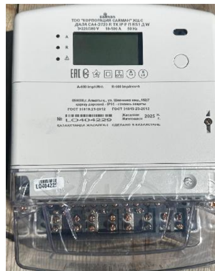
Электронный счетчик «Дала СА4-Э720 R TX IP P П RS Д G/PLC (10-100А 3x220/380В)» активной и реактивной энергии, трехфазный
