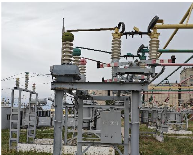
«До» замены трансформаторов напряжения 35 кВ
