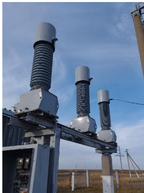
«После» замены трансформаторов напряжения 110 кВ
