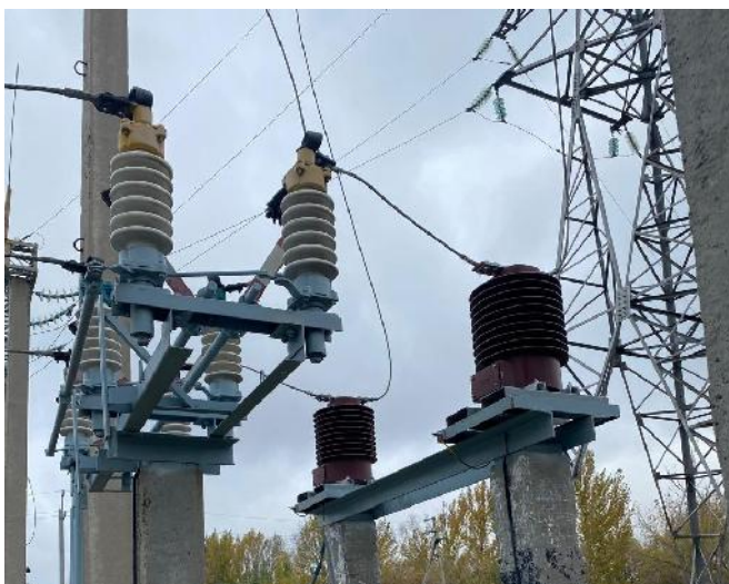
«После» замены трансформаторов тока 35 кВ
