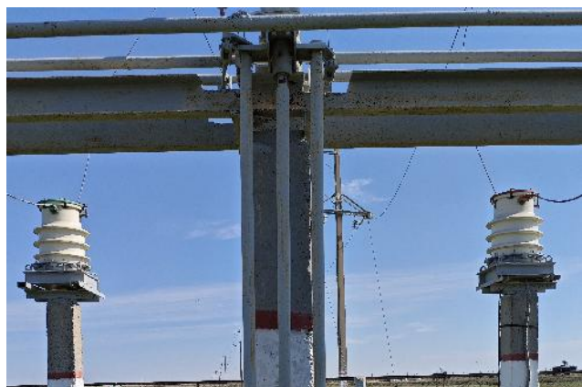
«До» замены трансформаторов напряжения 10 кВ
