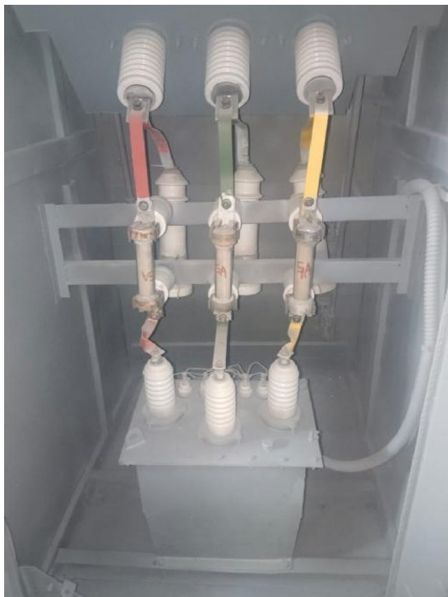
«До» замены трансформаторов напряжения 10 кВ
