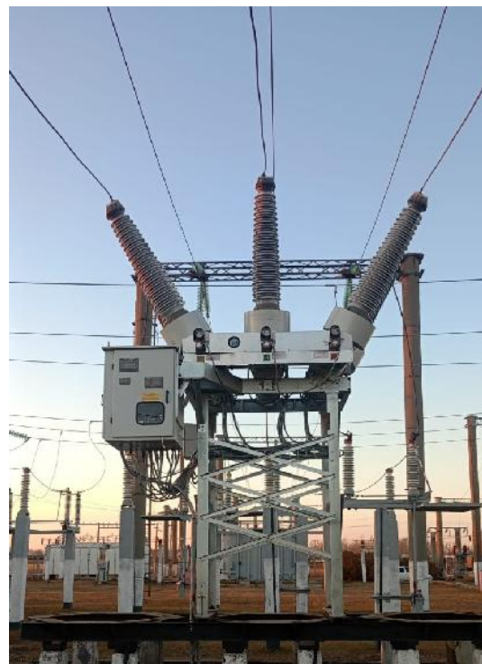
«После» монтажа элегазовых выключателей 110 кВ
