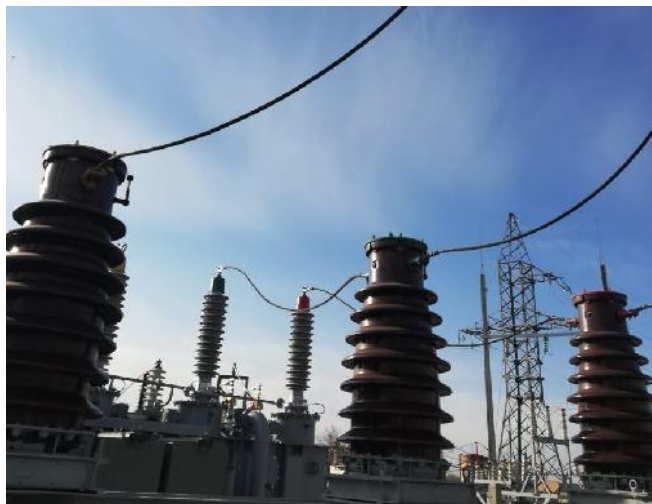
«До» замены трансформаторов тока 110 кВ
