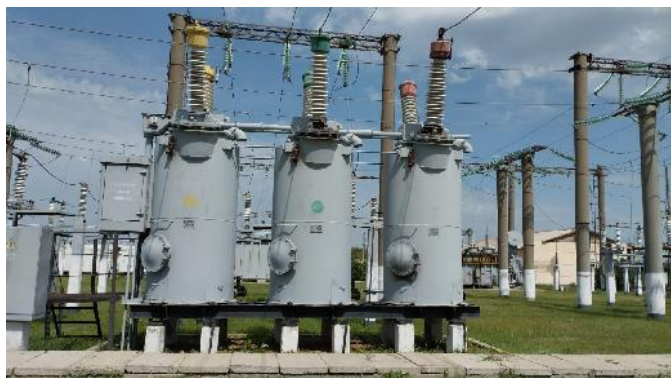
«До» замены масляных выключателей 110 кВ
