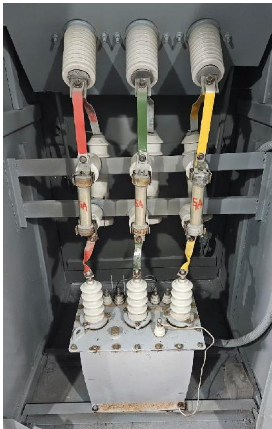
«После» замены трансформаторов напряжения 10 кВ
