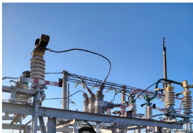
«После» монтажа вакуумных выключателей 35 кВ
