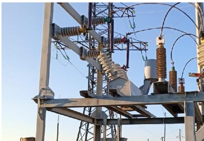
«После» замены трансформаторов напряжения 35 кВ
