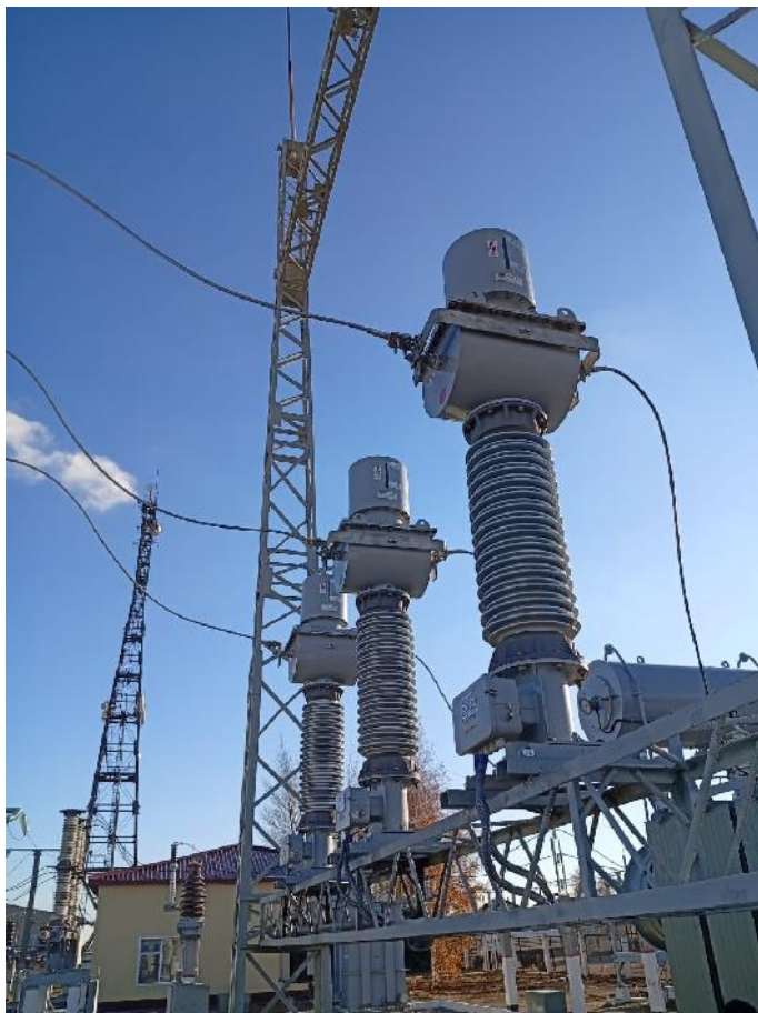
«После» замены трансформаторов тока 110 кВ
