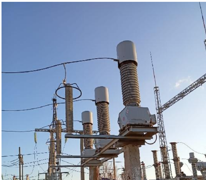
«После» замены трансформаторов напряжения 35 кВ
