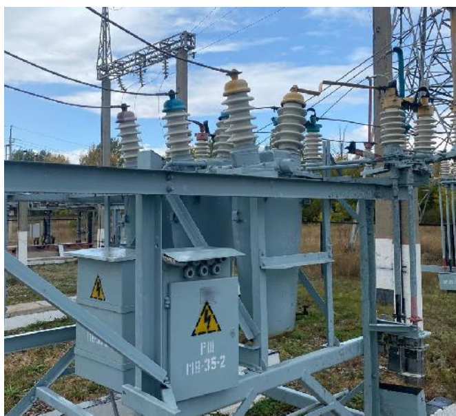
«До» замены трансформаторов тока 35 кВ
