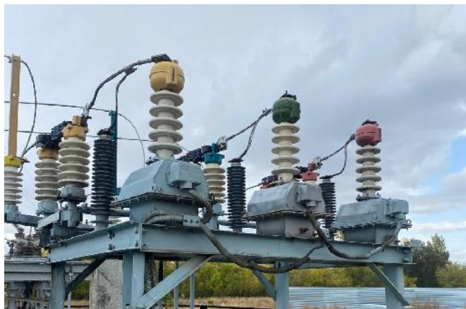
«До» замены трансформаторов напряжения 35 кВ
