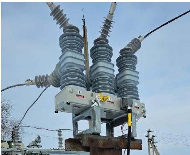
«После» монтажа вакуумных выключателей 35 кВ
