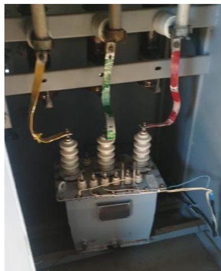
«После» после трансформаторов напряжения 10 кВ
