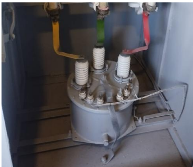
«До» замены трансформаторов напряжения 10 кВ
