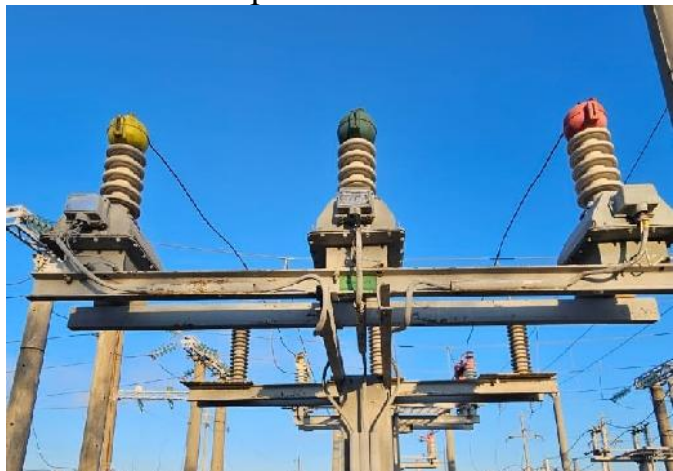
«До» замены трансформаторов напряжения 35 кВ
