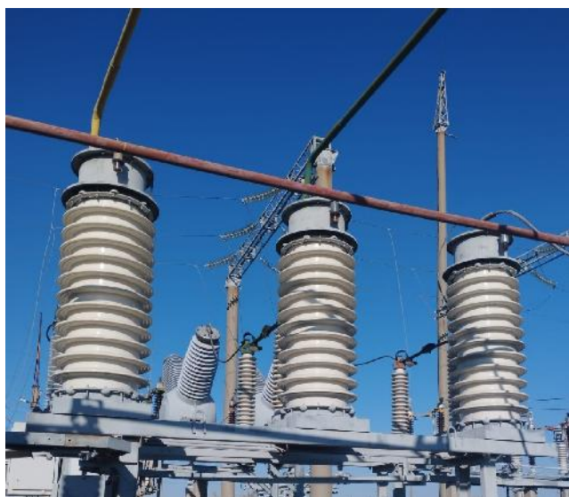
«До» замены трансформаторов напряжения 10 кВ
