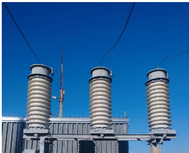
«До» замены трансформаторов напряжения 110 кВ
