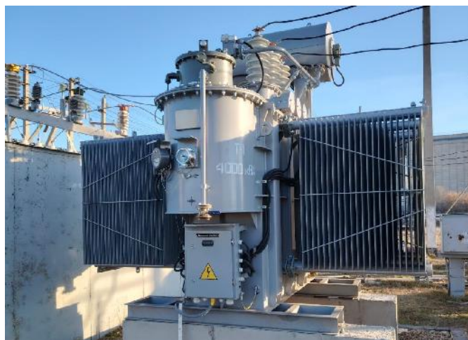
«После» замены силовых трансформаторов
