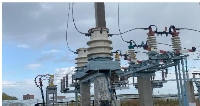
«До» замены трансформаторов тока 35 кВ
