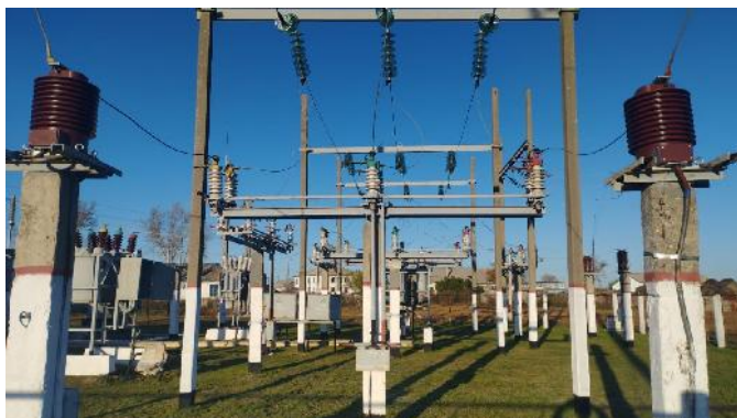
«После» замены трансформаторов тока 35 кВ
