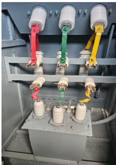
«До» замены трансформаторов напряжения 10 кВ
