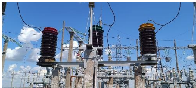
«До» замены трансформаторов напряжения 110 кВ
