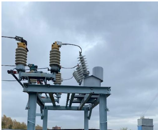
«После» трансформаторов напряжения 35 кВ
