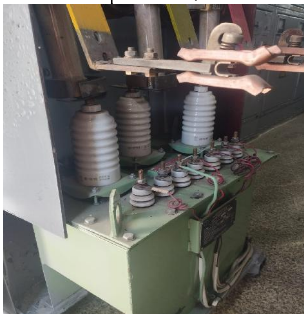
«До» замены трансформаторов напряжения 10 кВ
