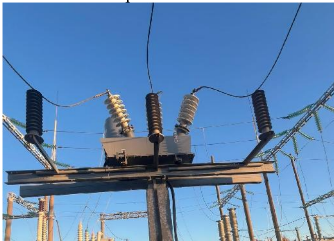
«После» замены трансформаторов напряжения 35 кВ
