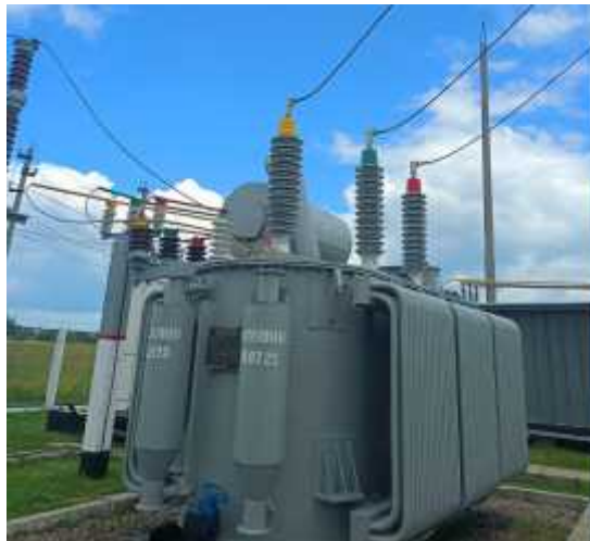
Фото после замены трансформаторов тока 110 кВ
