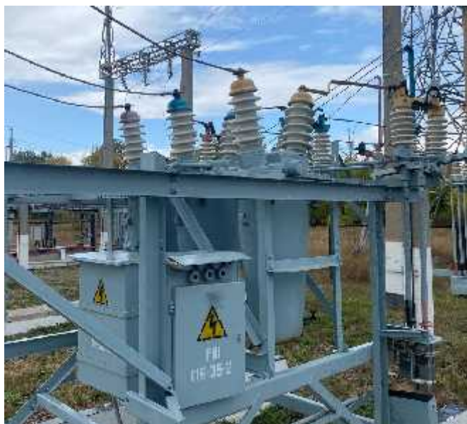
Фото до замены трансформаторов тока 35 кВ
