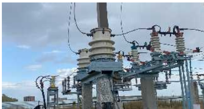
Фото до замены трансформаторов тока 35 кВ
