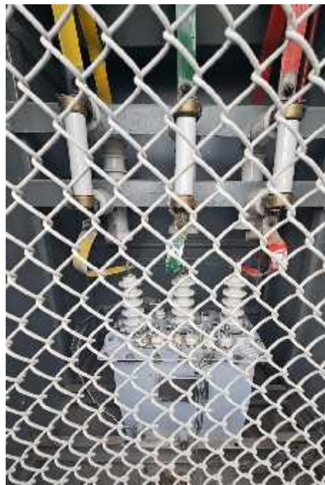
Фото после замены трансформаторов напряжения 10 кВ
