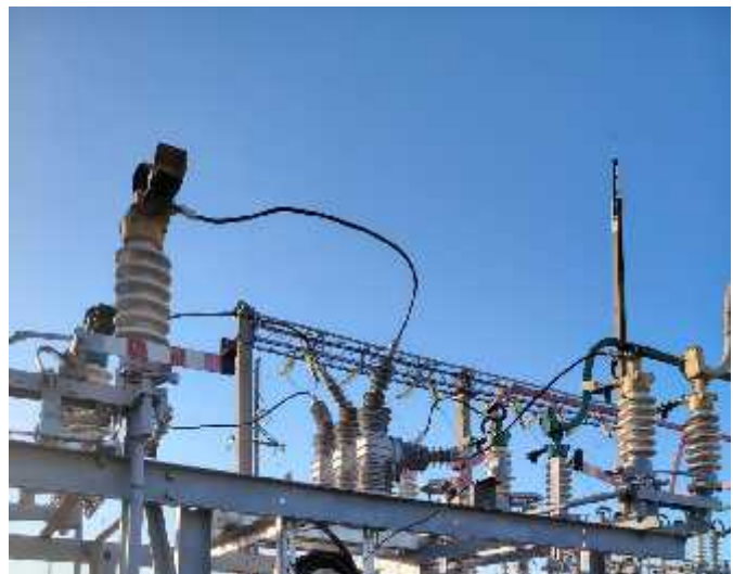
Фото после монтажа вакуумных выключателей 35 кВ
