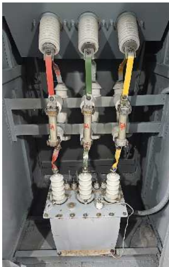
Фото после замены трансформаторов напряжения 10 кВ
