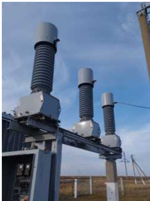
Фото после замены трансформаторов напряжения 110 кВ
