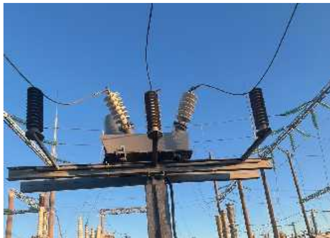
Фото после замены трансформаторов напряжения 35 кВ
