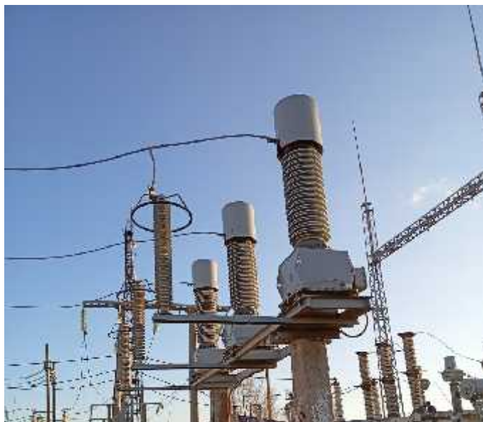
Фото после замены трансформаторов напряжения 35 кВ
