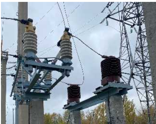
Фото после замены трансформаторов тока 35 кВ
