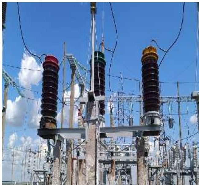
Фото до замены трансформаторов напряжения 35 кВ
