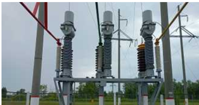
Фото после замены трансформаторов тока 110 кВ
