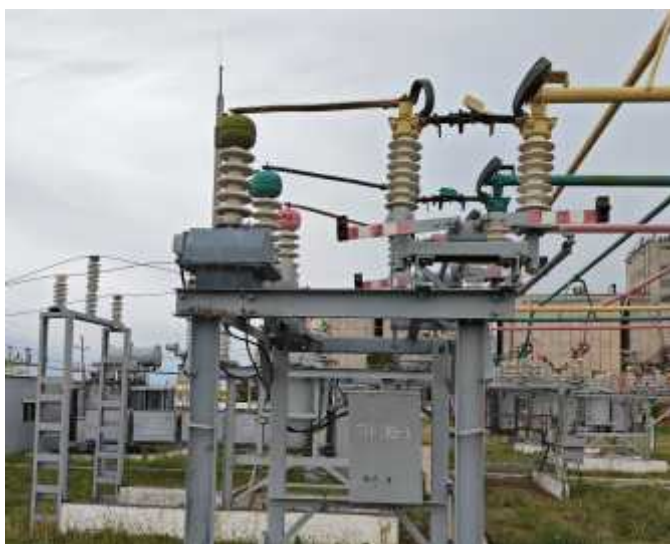
Фото до замены трансформаторов напряжения 35 кВ
