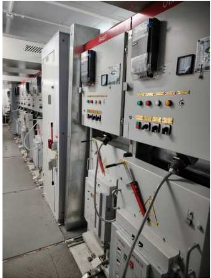
Фото после монтажа вакуумных выключателей 35 кВ
