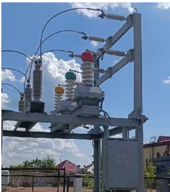
Фото до замены трансформаторов напряжения 35 кВ
