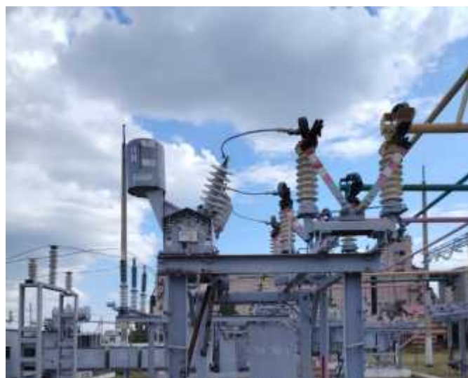
Фото после замены трансформаторов напряжения 35 кВ
