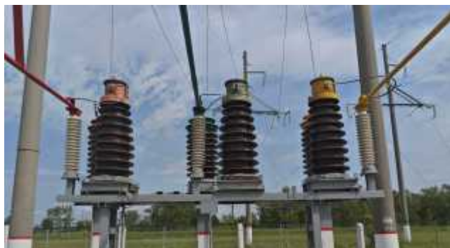
Фото до замены трансформаторов тока 110 кВ
