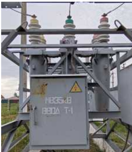
Фото до замены масляных выключателей 35 кВ
