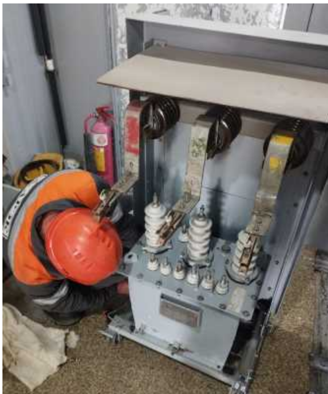
Фото после трансформаторов напряжения 10 кВ
