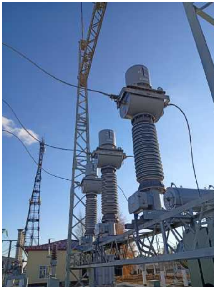
Фото после замены трансформаторов тока 110 кВ
