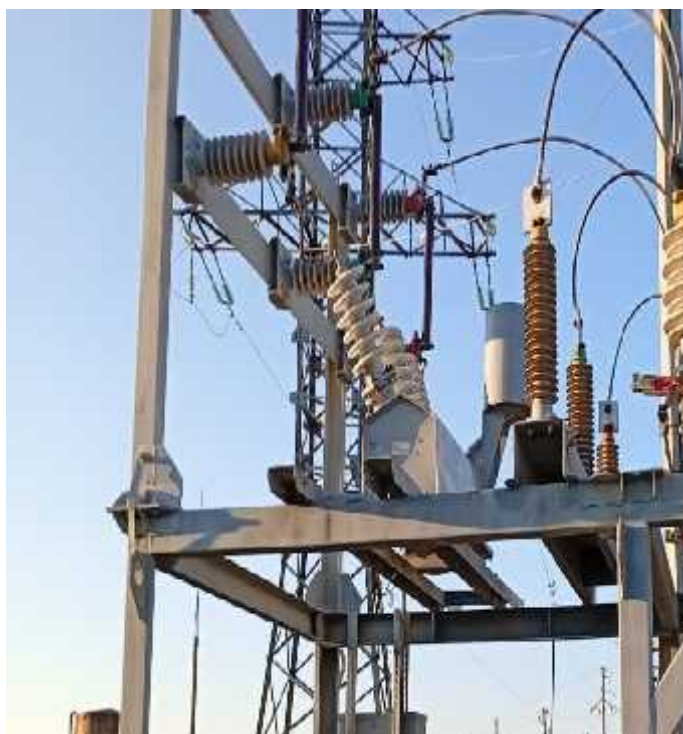
Фото после замены трансформаторов напряжения 35 кВ
