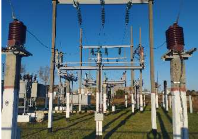
Фото после замены трансформаторов тока 35 кВ
