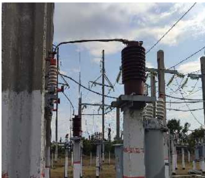
Фото после замены трансформаторов тока 35 кВ
