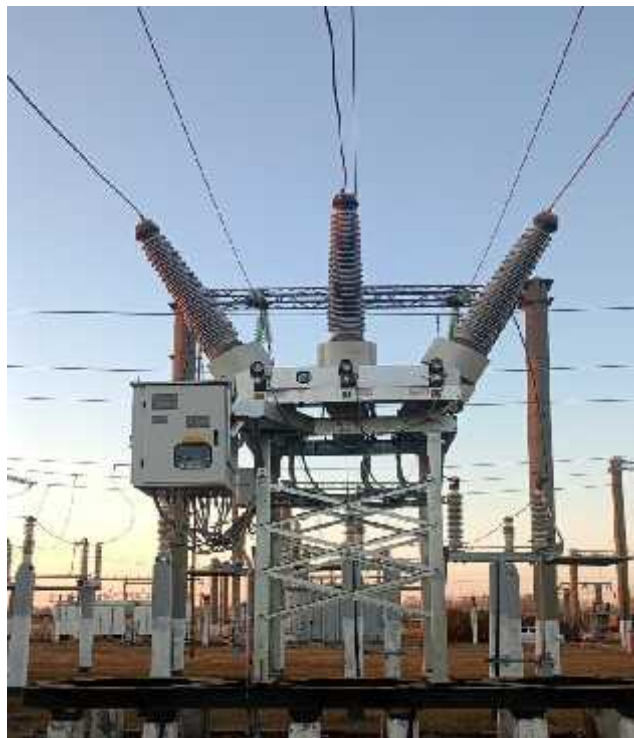
Фото после монтажа элегазовых выключателей 110 кВ
