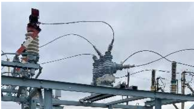
Фото после монтажа вакуумных выключателей 35 кВ
